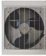
An den Ventilator-schaukeln entstehen Wirbel und Druckschwankungen, die als Lärm abgestrahlt werden.
