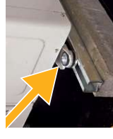
Gummipuffer helfen, den Körperschall zu reduzieren.
